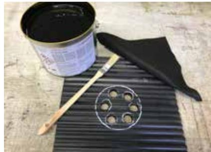
Um eine Verstopfung des Bodeneinlaufes durch Feinanteile im Schotter zu vermeiden, kann ein wasserdurchlässiges Flies über die Entwässerung geklebt werden. Hierfür das Flies einfach in den noch flüssigen Kleber G 2010 plus einlegen.
