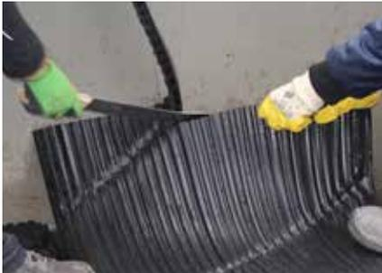
Die Stöße lassen sich mittels Knüpfverbindung koppeln. Hierbei ist ein 50/50 Gemisch aus Seife und Wasser zu verwenden.
