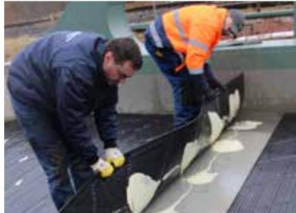
Bodenmatten werden punktuell mit einem lösungsmittelfreiem 2K-PU-Kleber verklebt (ca. 350g/m<sup>2</sup>) im Mischungsverhältnis 10 kg Harz zu 2 kg Härter.
