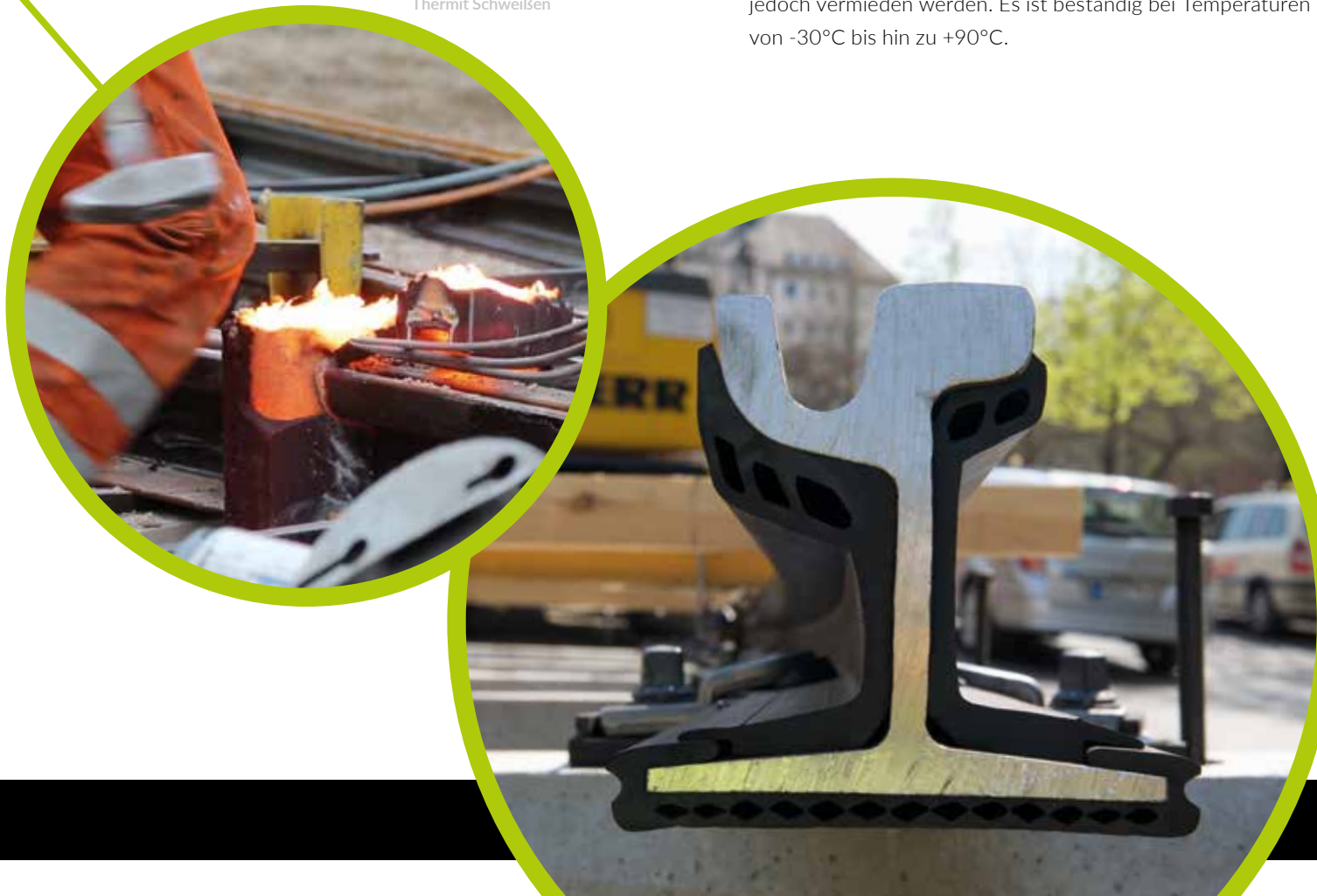
Verbindungsschweißen der Schienen mittels Thermit Schweißen
